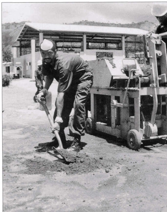
Bild 3: Nassmischen des Ausgangsmaterials vor dem Pressen
