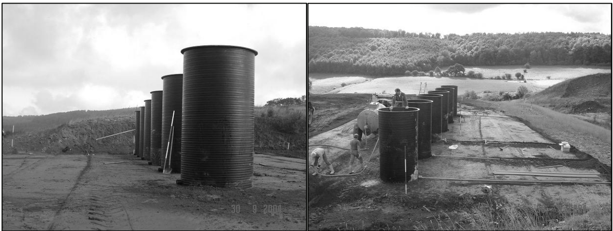
Abb. 7.1-2: Links: Lysimeter aufgestellt auf dem Planum aus gewalztem Stabilisat. Rechts: Anschluss der Rohre zur Erfassung des Sickerwassers.
