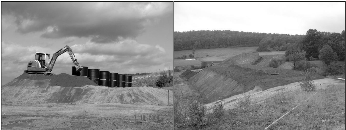
Abb. 7.1-5: Herstellung des Lysimeterumfeldes und des Gehölzfeldes.
