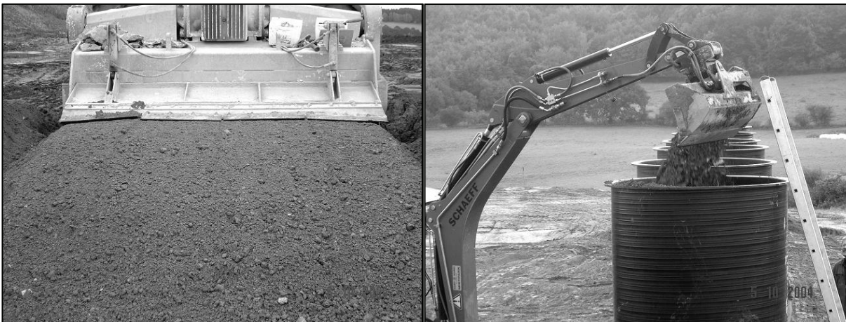
Abb. 7.1-4: Herstellung der Gemische mittels Hochleistungsfräse und Befüllung der Lysimeter mit einem Bagger.
