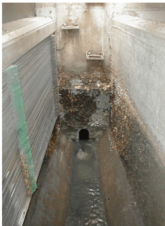
Abbildung A4.4: Verringerung des Drosselabflusses der Vorstufe mittels Schütztafel, RBF Fellenweg (Waldhoff 2008)
