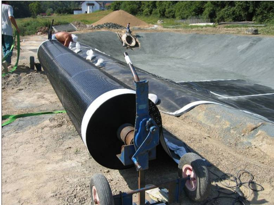
Abbildung A4.11: Verlegen der Kunststoff-Basisabdichtung, RBF Kleingladenbach (Frechen et al. 2008)
