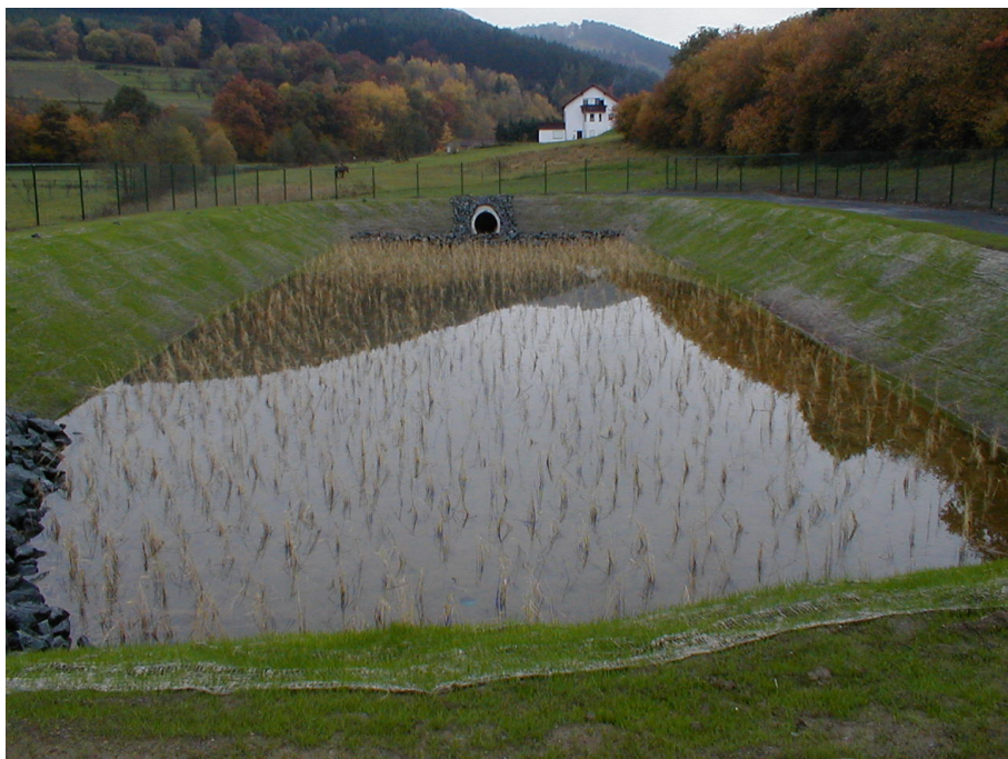
Abbildung A4.16: Einstau des Filterbeckens zur Anwuchspflege, RBF Kleingladenbach (Frechen et al. 2008)
