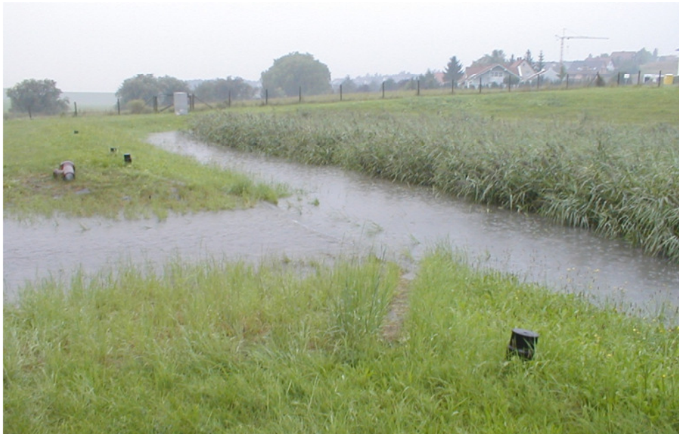
Abbildung A4.5: Einstau des Retentionsraumes mit Filterbeckenüberlauf, RBF Fellenweg
