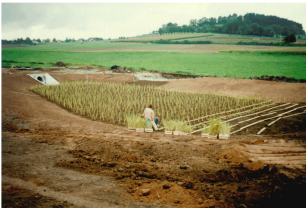
Abbildung A4.3: Bepflanzung der Filteroberfläche, RBF Fellenweg (Waldhoff 2008)
