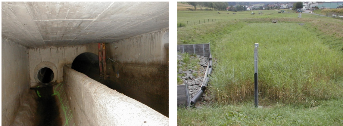
Abbildung 15: RBFA Wiesenbach mit Überlaufbauwerk der Vorstufe vor Einbau des Feinrechens (li.) und RBF in 2006 (re.)
