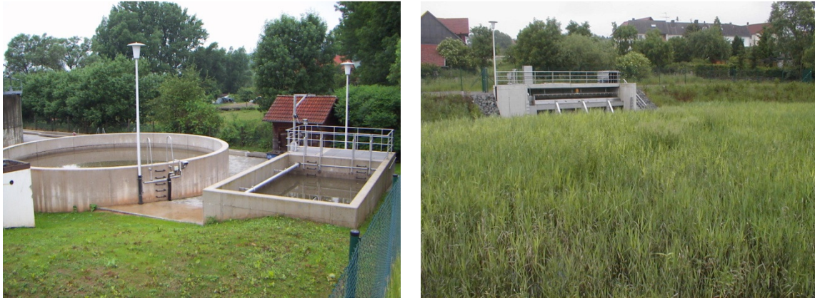
Abbildung 19: RBFA Oberelsungen mit Vorstufe und Trennbauwerk (li.) und RBF in 2005 (re.)
