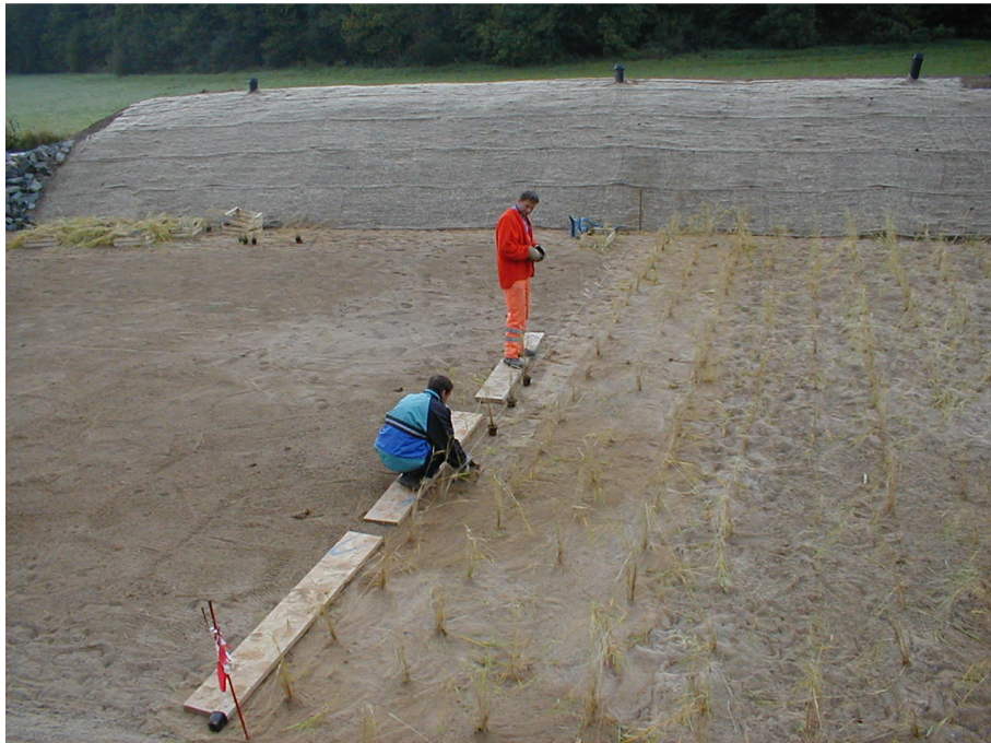
Abbildung A4.15: Bepflanzung der Filteroberfläche, RBF Kleingladenbach (Frechen et al. 2008)
