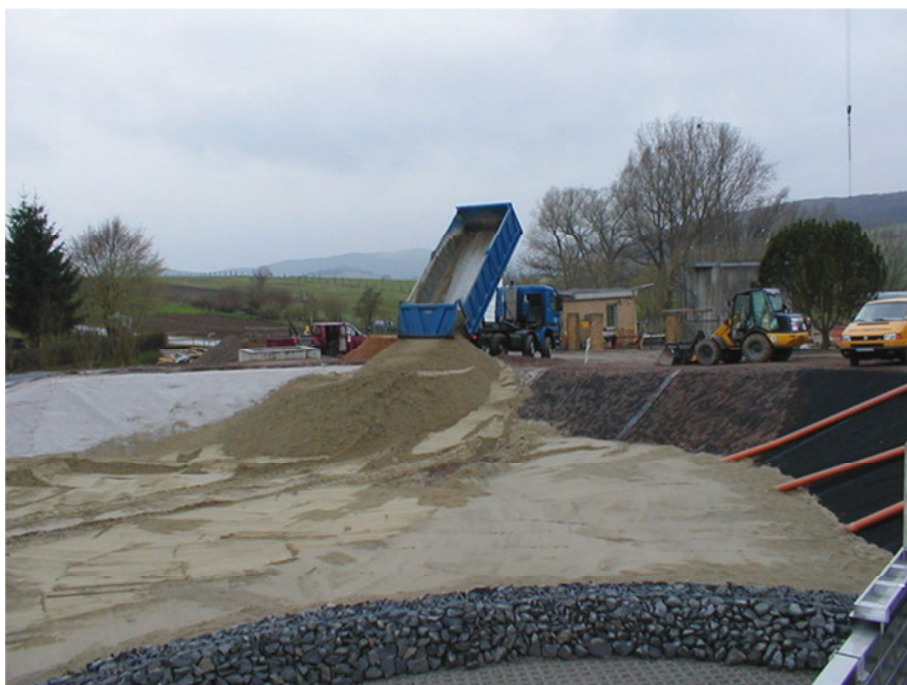
Abbildung A4.20: Einbau des Filtersubstrates, RBF Oberelsungen (Waldhoff 2008)
