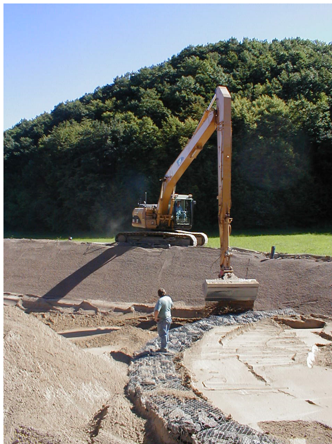
Abbildung A4.14: Einbau des Filtersubstrates mit Teleskop-Bagger, RBF Kleingladenbach
