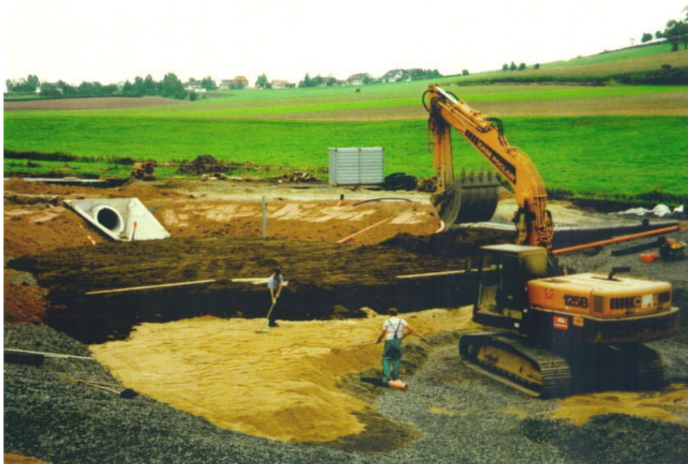
Abbildung A4.2: Einbau der Dränage und des Filtersubstrates, RBF Fellenweg (Waldhoff 2008)
