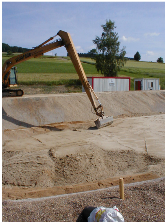
Abbildung A4.8: Einbau des Filtersubstrates, RBF Wiesenbach (Frechen et al. 2008)
