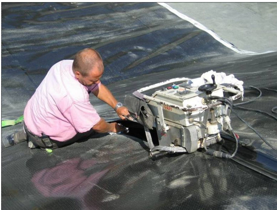
Abbildung A4.12: Verschweißen der einzelnen Bahnen der Kunststoff-Basisabdichtung, RBF Kleingladenbach (Felmeden 2005)
