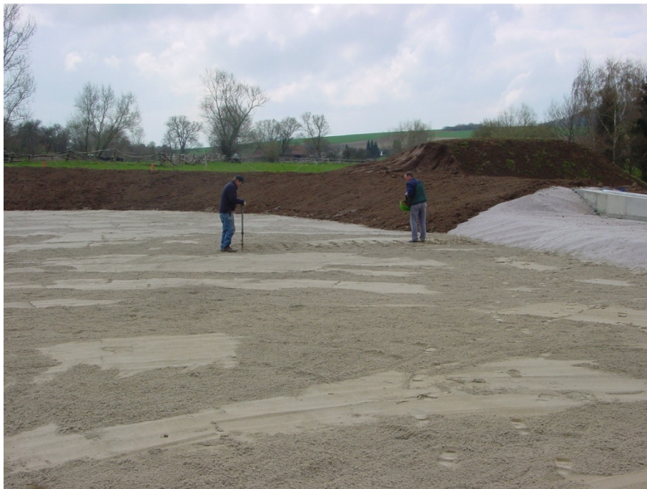
Abbildung A4.21: Bepflanzung der Filteroberfläche, RBF Oberelsungen (Frechen et al. 2008)
