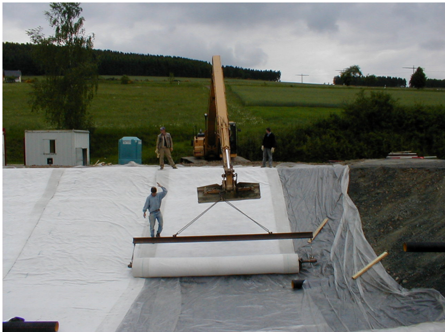
Abbildung A4.6: Erstellen der Basisabdichtung, RBF Wiesenbach (Frechen et al. 2008)
