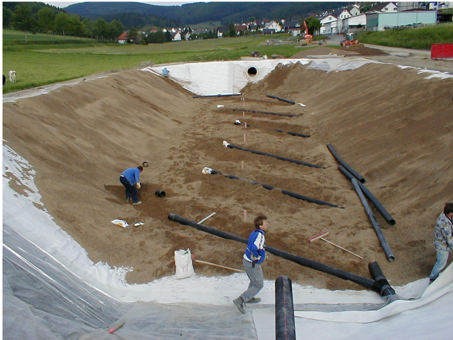
Abbildung A4.7: Herstellen des Dränagesystems, RBF Wiesenbach (Frechen et al. 2008)
