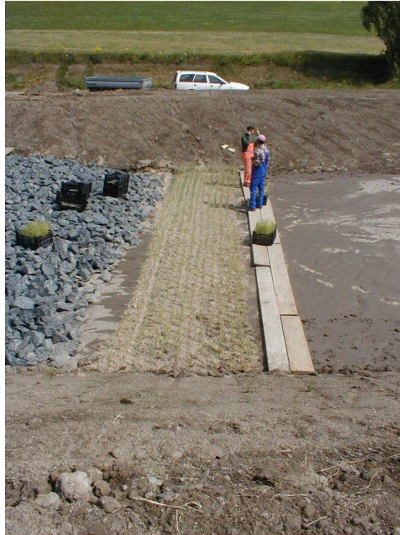
Abbildung A4.9: Bepflanzung der Filteroberfläche, RBF Wiesenbach (Frechen et al. 2008)
