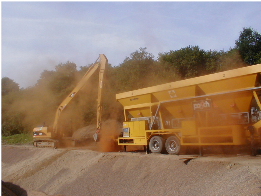
Abbildung A4.13: Melioration des Filtersubstrates mit Eisenhydroxid mittels mobiler Dosieranlage, RBF Kleingladenbach (Frechen et al. 2008)
