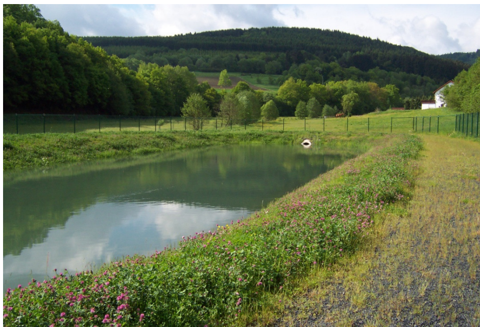
Abbildung A4.17: Aufstau des Retentionsraumes nach Beschickungsereignis, RBF Kleingladenbach (Frechen et al. 2008)
