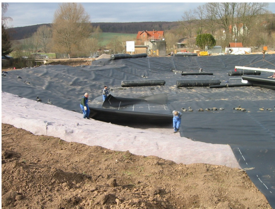
Abbildung A4.18: Erstellen der Basisabdichtung, RBF Oberelsungen (Frechen et al. 2008)
