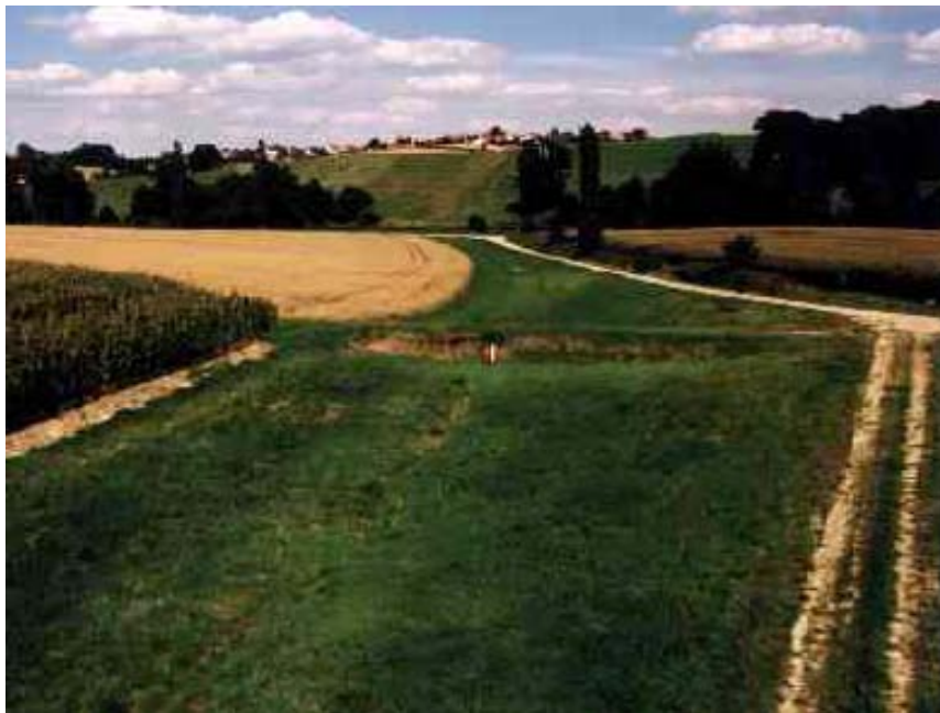
Abb. 43: Beispiel einer begrünten Abflussmulde (Auerswald, 2004)
