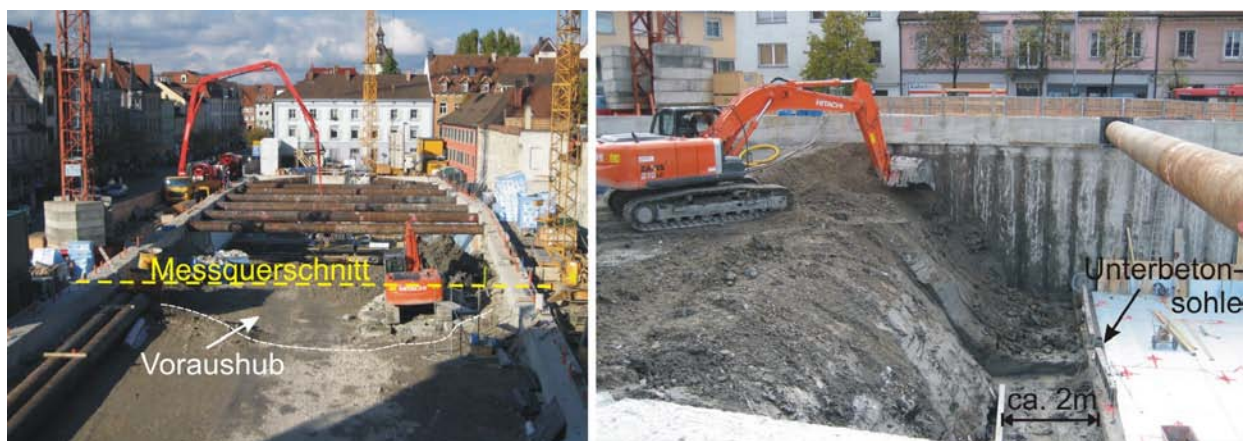
Bild 6.22: Konstruktionsdetails zum abschnittweisen Aushub
