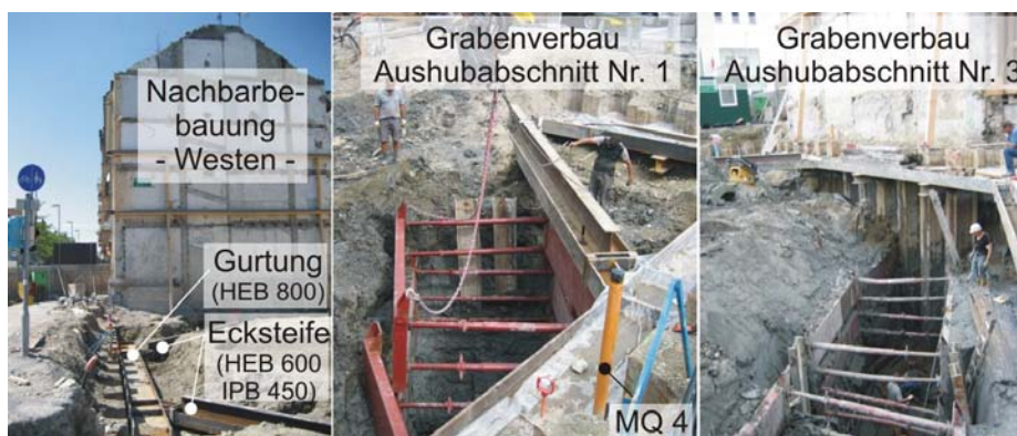
Bild 6.41: Einbau der oberen und unteren Aussteifung
