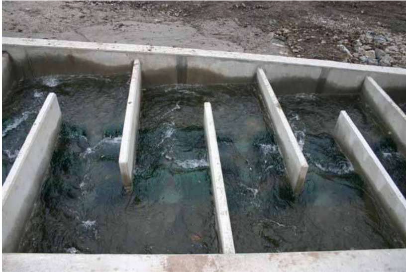
Bild 3: Gefalteter Fischpass mit 3-fach-Riegeln (rechnerische Leistungsdichte in den Becken 53 \text{ W/m}^3 bei 240 \text{ l/s} , Lückenbreite 30 \text{ cm} )
