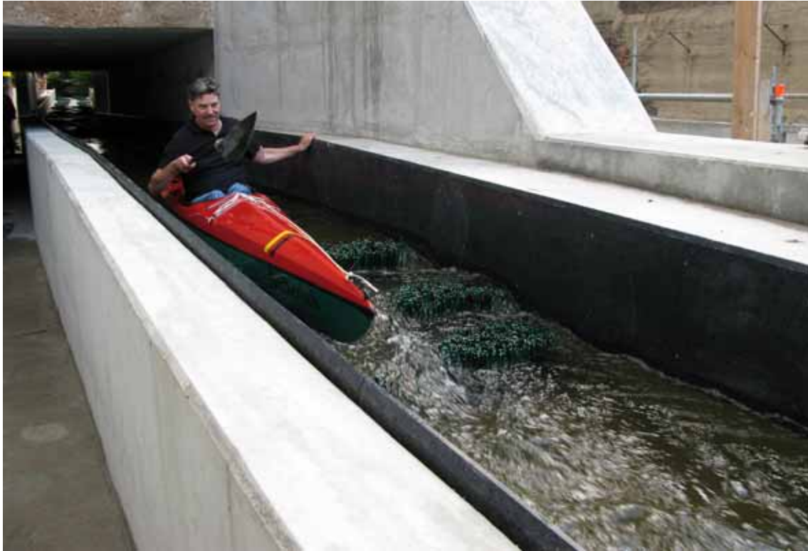
Bild 9: Fisch-Kanu-Pass am Wehr Bahnhofstraße in Fürstenberg/Havel mit Treidelgang links und Schrammborden (verminderte Wasserführung)
